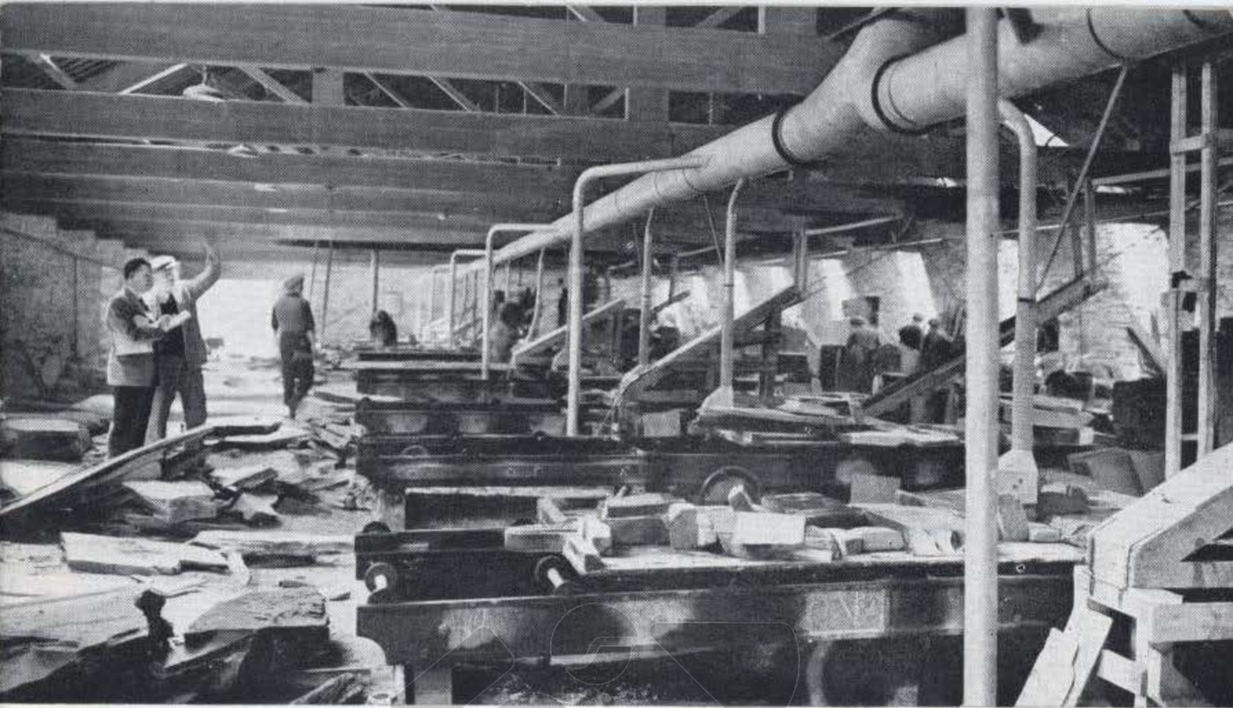
New Installation, Bonc Shaftt.
